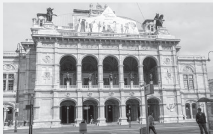
Architektov budovy Štátnej opery postihol smutný osud
